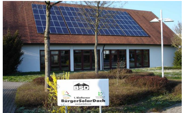
Das Bürgersolardach auf dem Bürgerhaus Kluffern.
